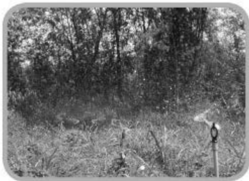
ภาพที่ 8 ระบบสปริงเกอร์
